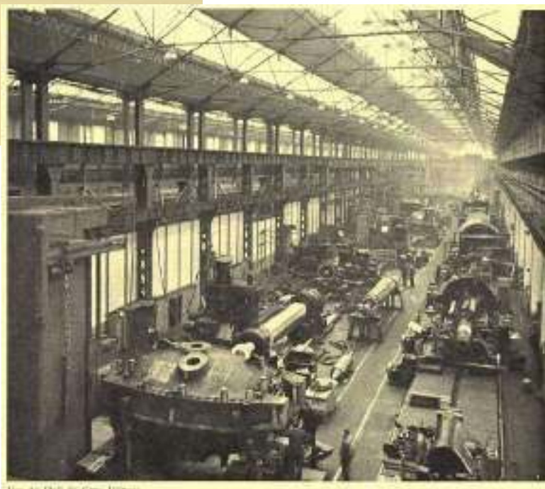
Vue de l'intérieur de l'usine.
