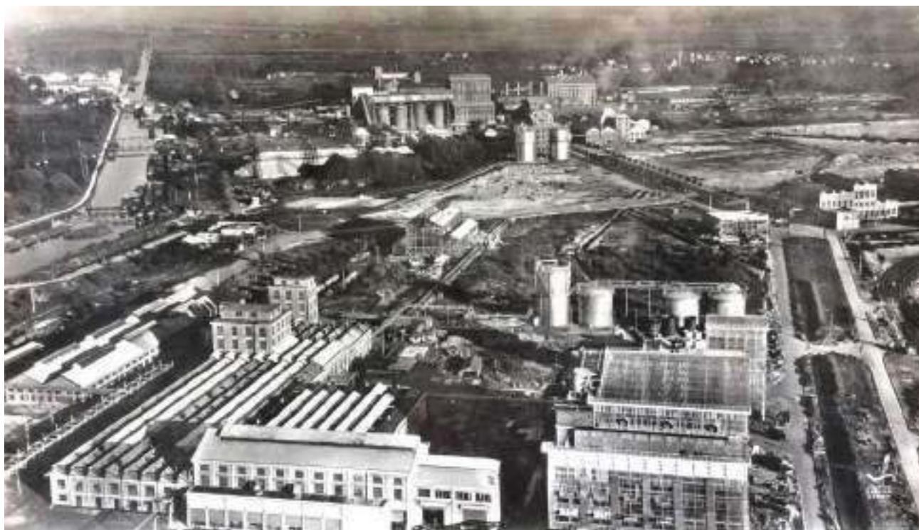
AD39, « La grande industrie chimique : Les usines Solvay, Damparis », Documentation aérienne pédagogique Lapie, Saint-Maur, 6Fi16 (Tous droits réservés)
