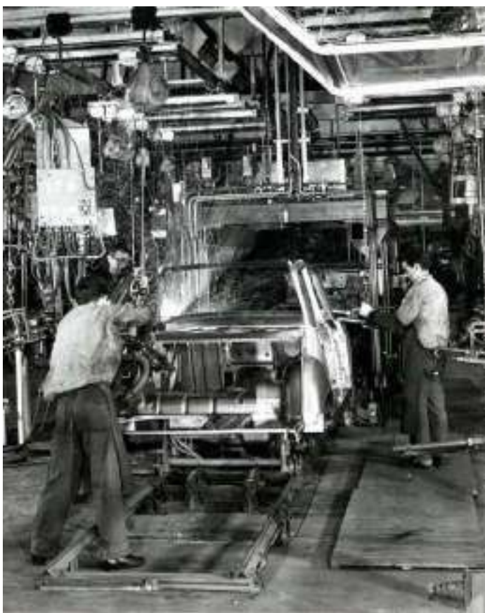
3-Emboutissage et assemblage des pavillons par soudure électrique
